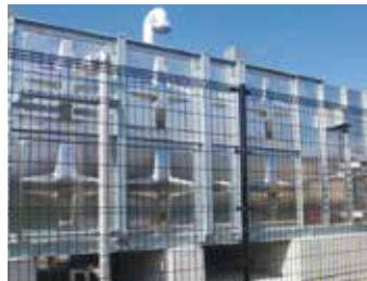
受水槽の管理・清掃
