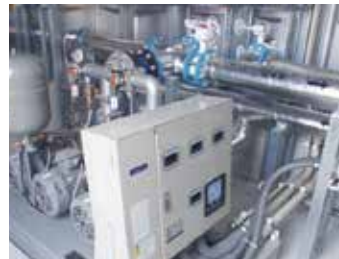
ポンプの更新 (交換)
